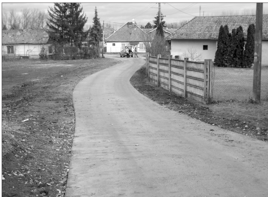
A csatorna-hálózat kiépítését követően a Sládkovič utca képe lassan változik. Az úttestet lebetonozták, ez képezi majd a leendő út alapját, amelyet az év folyamán aszfaltréteggel fednek le. (fotót: rl)
