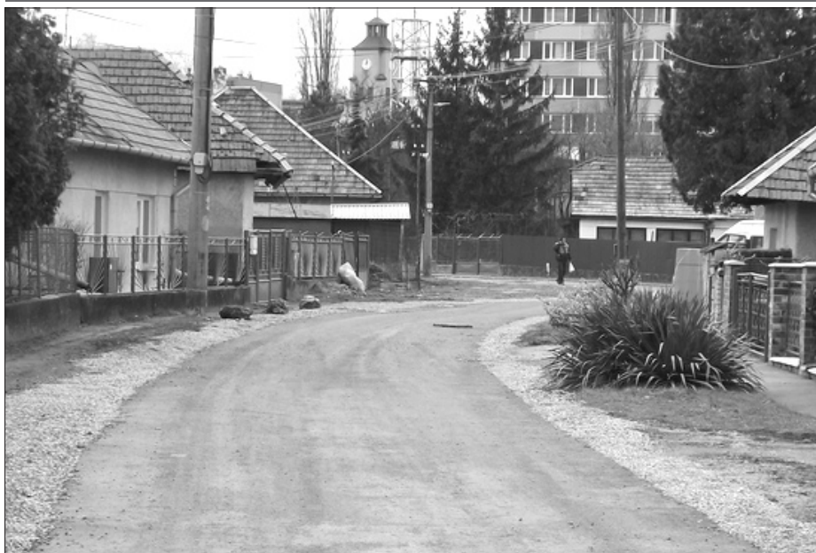
Po dokončení kanalizácie sa Sládkovičova ulica pomaly mení. V súčasnosti ju pokrýva betónová vrstva, tvoriaca základ povrchu budúcej cestnej komunikácie. Asfaltom sa pokryje v priebehu roka. (fotot: rl)
