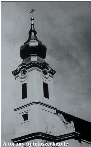
A torony új tetőszerkezete
