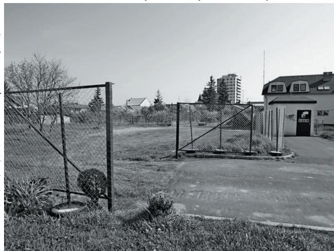
Také bolo stavenisko 8. apríla
