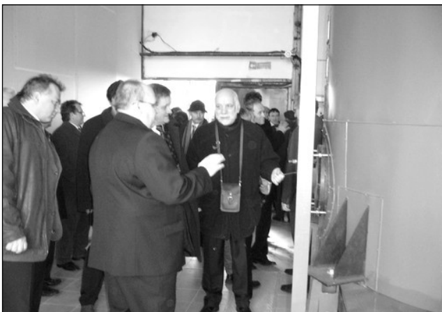
Kotolňa na Mierovej ulici bude po sprevádzkovaní druhého kotla na spaľovanie slamy schopná vykurovať celé mesto. Viac v budúcom čísle.
