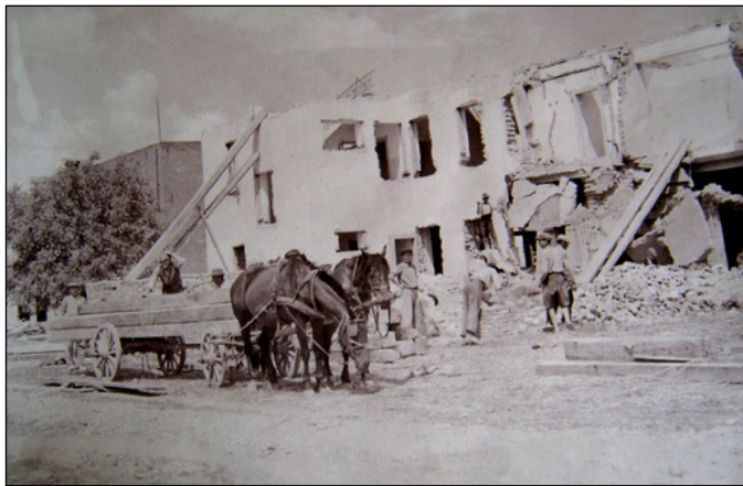
Rozbombardované centrum Želiezoviec
