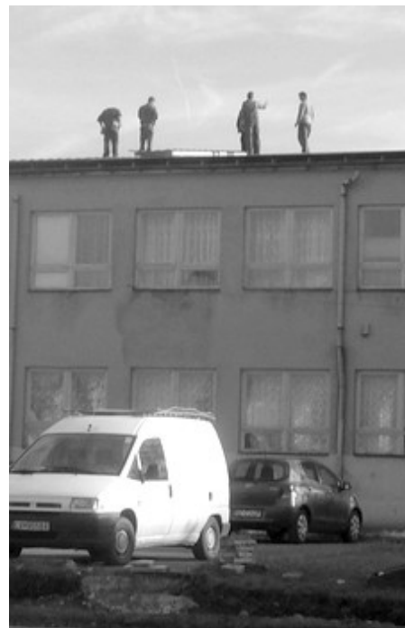
Október végén elkezdődött a magyar alapiskola új épületének tetőfelújítása, amelyet a zselízi D+G Kft. valósít meg.
