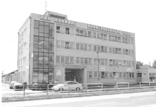
Súčasťou jedného z projektov je aj rekonštrukcia domu služieb
