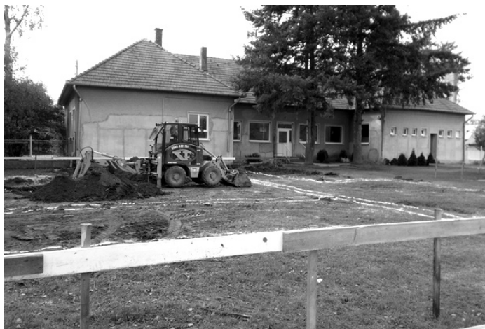
V októbri sa začali práce na prístavbe a rekonštrukcii materskej školy v Mikule. V prvom kroku boli vybudované základy plánovanej prístavby budovy. (foto: gb)
