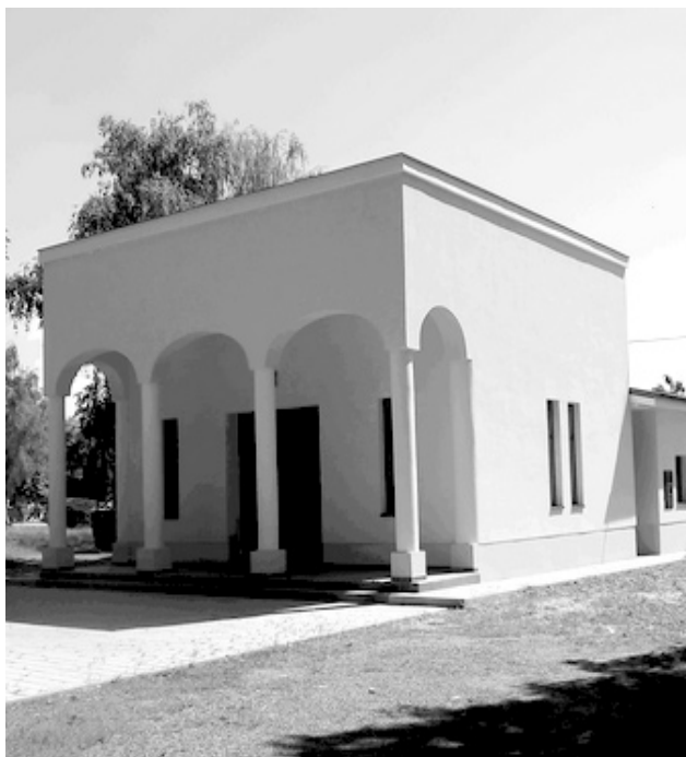
Modernizácia vybavenia mestských cintorínov pokračuje aj v tomto roku. V lete prebehla rekonštrukcia chladiaceho zariadenia v želiezovskom dome smútku za 4110 eur. (foto: ik)
