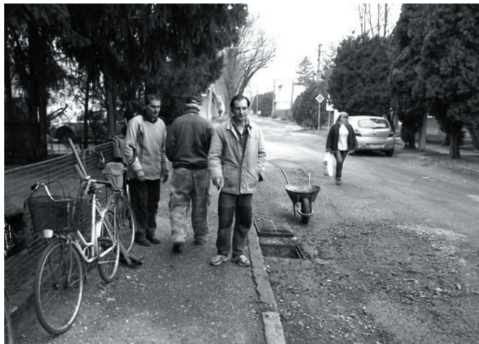
Mláky na križovatke Nemocničnej a Komenského ulice spôsobujú ľuďom ťažkosti už desaťročia. Napriek tomu, že sa voda prečerpáva, pri topení snehu alebo intenzívnejších dažďoch i tak zaleje začiatok ulice. Následne sa vytvárajú výtlky. Jeden z veľkých a nebezpečných bol odstránený začiatkom marca.
