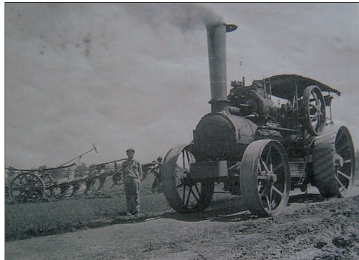
Mohutný parný stroj, aký prelomil starý kamenný most
